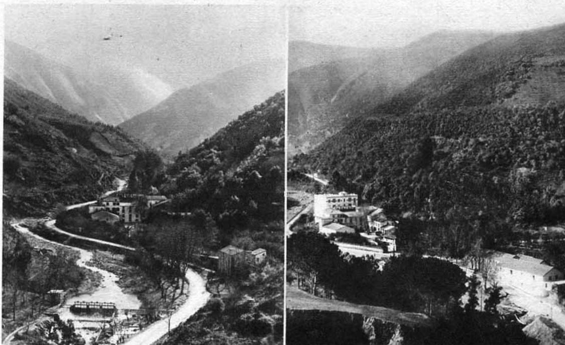
La vallée de l'oued El Kebir et les Grands Moulins. — A gauche, les anciennes usines; à droite, les usines nouvelles.
