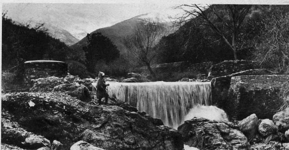
Barrage dans la vallée de l'oued El Kebir.
