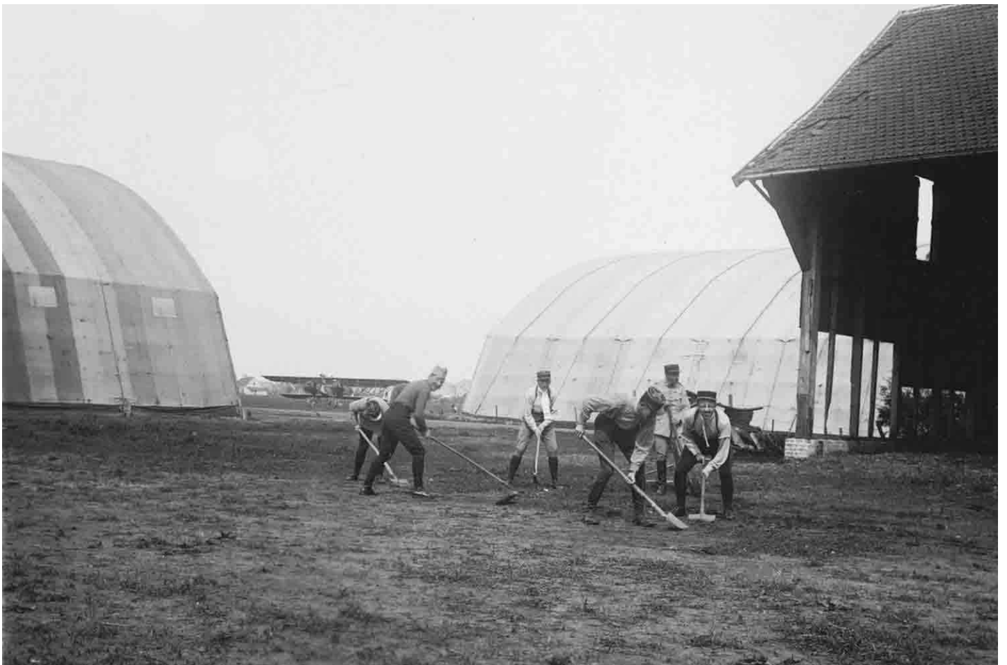
▼ Réparation des dégâts des bombardements
