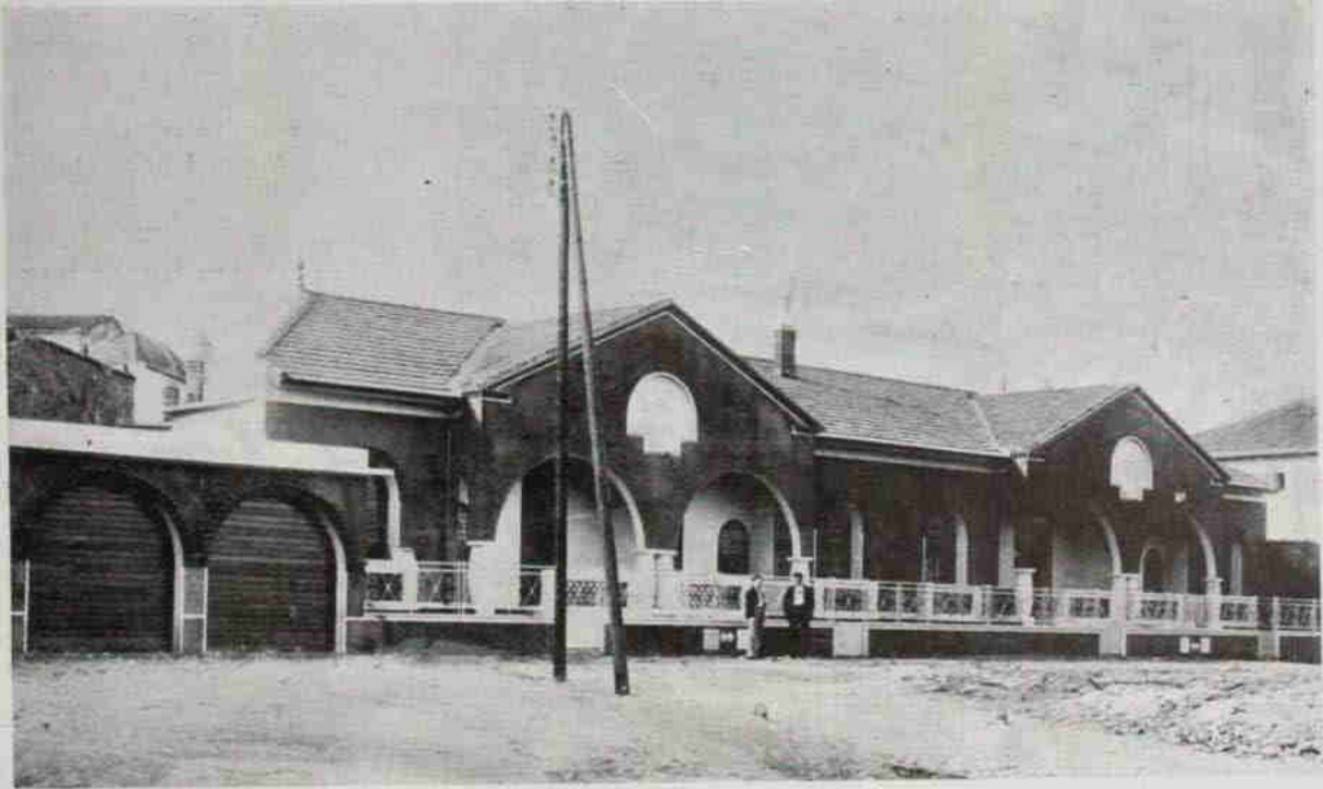
Villa-chalet à Blida (lotissement Torrègrossa) Armand COMBE, architecte E. B. A.
